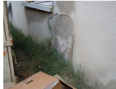
Traces d'humidité et enduit extérieur dégradé
