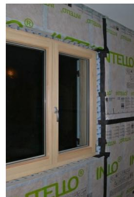
ITI sur ossature métallique avec freine-vapeur hygrovariable
