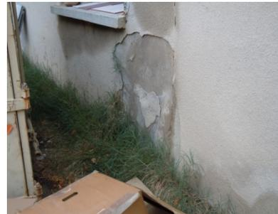
Traces d'humidité et enduit extérieur dégragé
