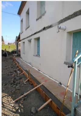
Exemple d'isolation périphérique horizontale sous chape, largeur 1m,  $R=3 \text{ m}^2.K/W$
